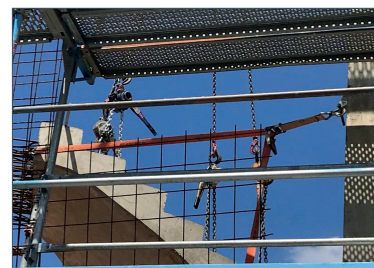
Positionierungsarbeiten bei dynamischen Lasten
